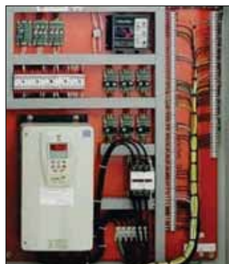
▲ Quadro de Comando Novo - Modernizado
